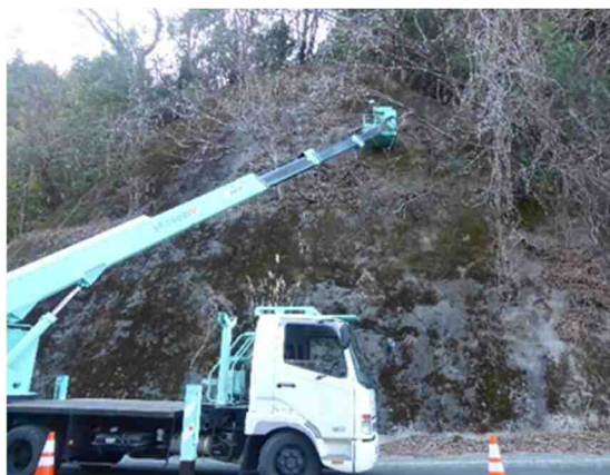
写真 2-3 高所作業車による近接目視
