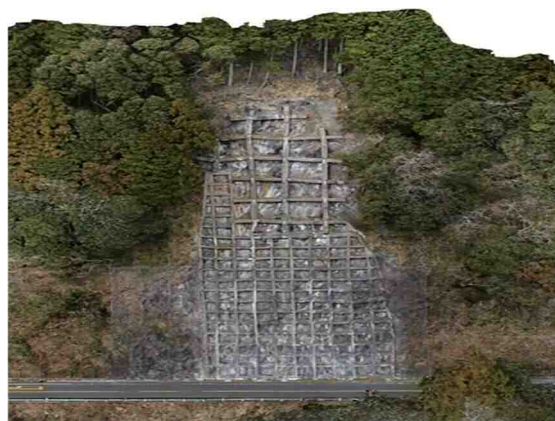
写真 2-1 長大切土（モルタル吹付・法枠）
