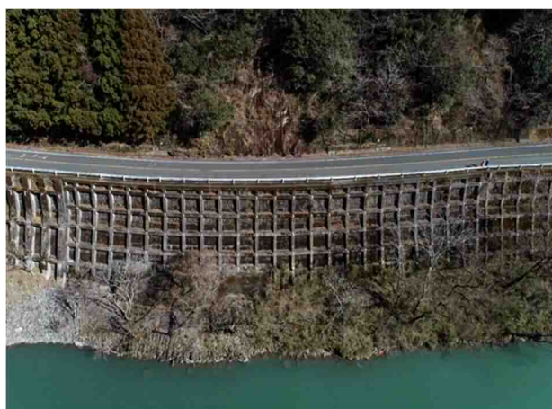
写真 2-2 高盛土（法枠・グラウンドアンカー）
