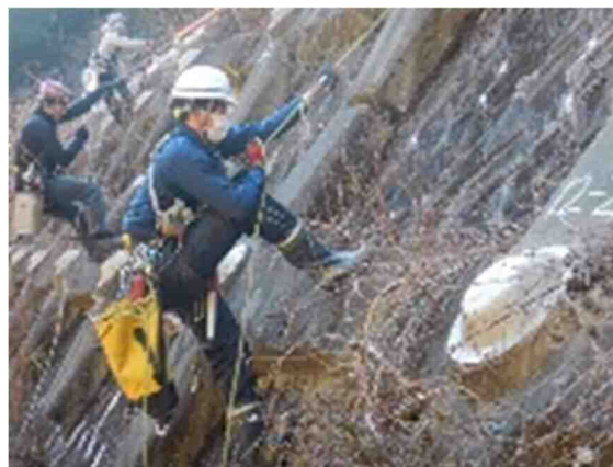
写真 2-4 ロープアクセスによる近接目視
