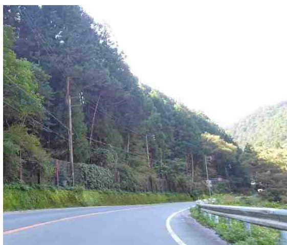
写真 2-1 道路斜面（天竜区）
