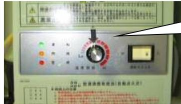
ダイヤルで給湯温度の設定を調整可能。矢印で設定を指示。
