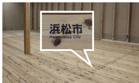
事務所の柱や床に天竜材が使用されている選手村ピレシジプラザ
