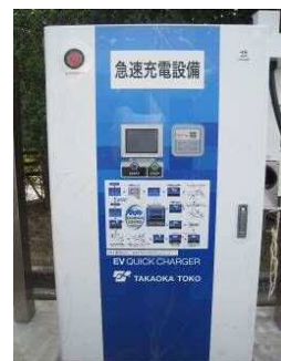
電気自動車用急速充電器
