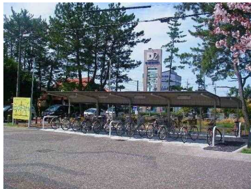
サイクル&ライド用に整備された駐輪場
