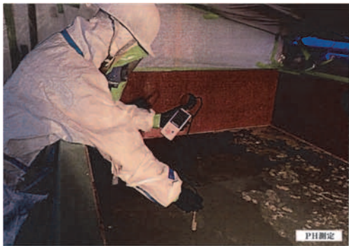
写真 3 pH の測定
