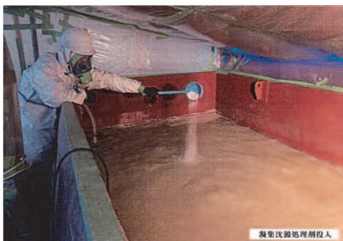
写真 5 凝集沈殿処理剤投入
