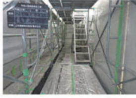
足場内部の養生(例)
