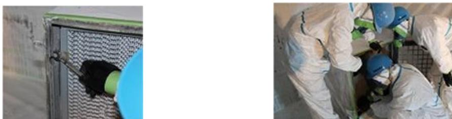
写真Ⅶ-9 HEPAフィルタの留め付の緩み点検
