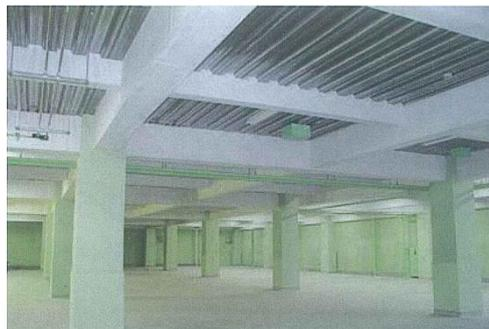
写真Ⅱ-19 けい酸カルシウム板第二種を耐火被覆として使用している例
