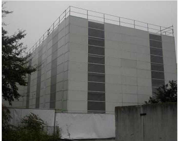
写真－2 防音パネル／採光防音パネル施工例
