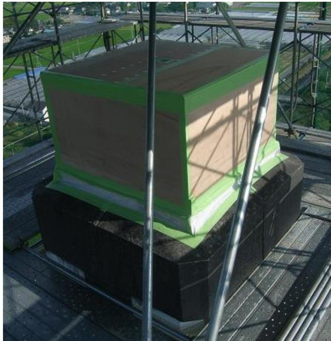
写真－3 煙突開口部養生例
