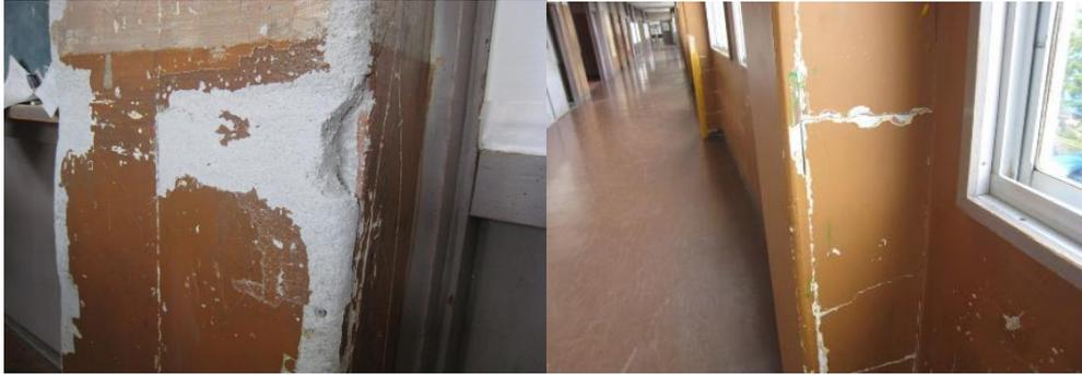
写真 II-20 鉄骨造校舎 教室・廊下の柱 長年の接触により欠損している
