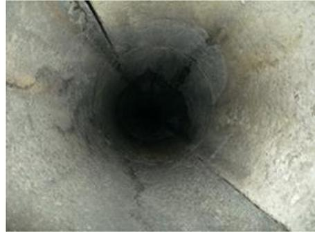
写真Ⅱ-10 煙突用断熱材ハイスタック
