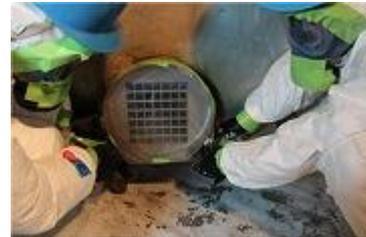
写真Ⅶ-4 集じん・排気装置の排気口をプラスチックシート等で封鎖
