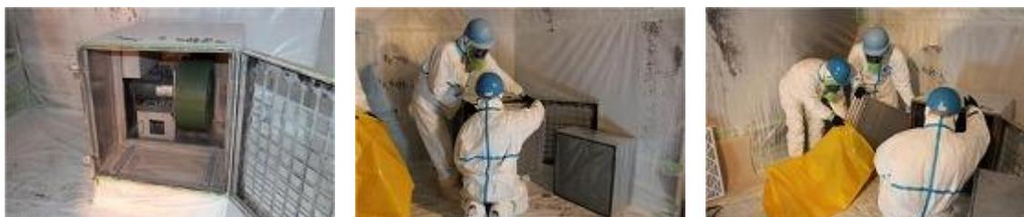
写真Ⅶ-10 HEPAフィルタの交換
