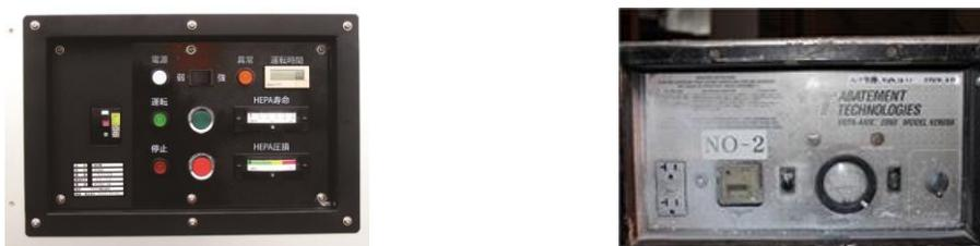
図-21 差圧計の取り付けられたコントロールパネル例
