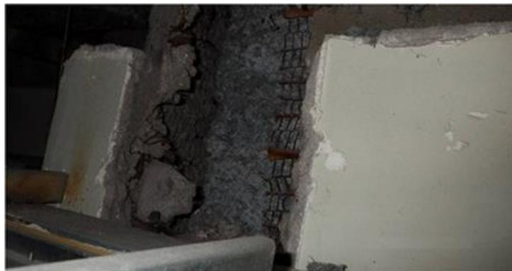
写真Ⅱ-13 壁の中に青石綿が吹かれラス網の上モルタル+プラスター塗り仕上げ
