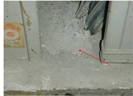
写真Ⅱ-12 電気配線部分隙間閉鎖
