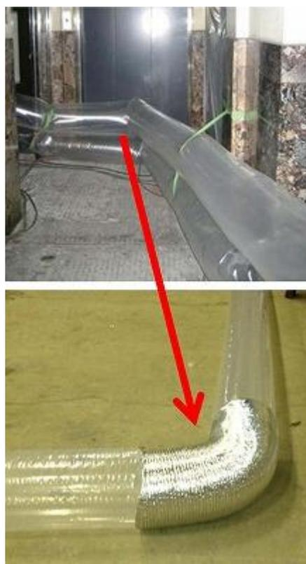
図-14 ビニールダクトの曲がり部分に環状の支え（アルミ製ダクト）をビニールダクトに重ねて使用した例
