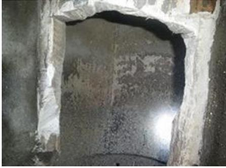
写真Ⅱ-9 ハイスタック煙突断熱材
