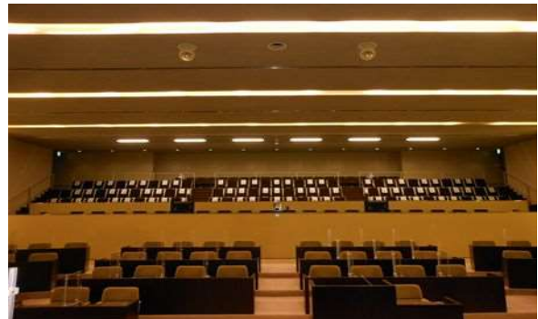
本庁舎議場照明更新工事
