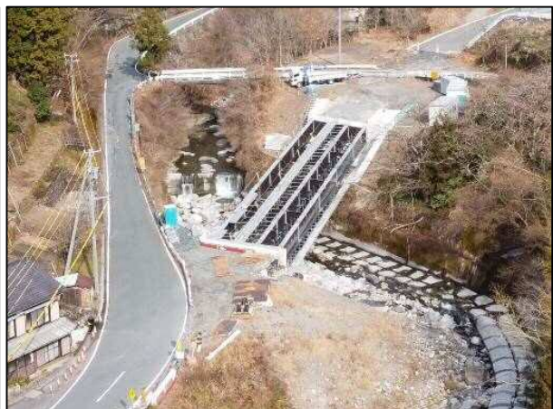
▲(国)152号(池島・大原区間)道路改良事業
