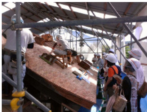
区域内における指定文化財での修復事業の計画的な遂行 (宝林寺山門修復時の一般見学会の様子)
