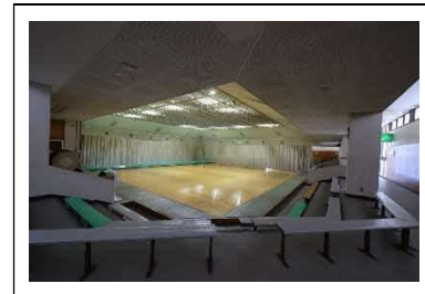
⑥A面 北西角より
