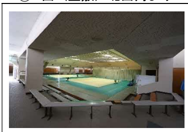
⑭C面 (畳敷) 北東角より
