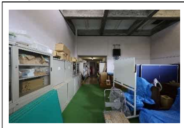
⑲準備室 南側より北側
