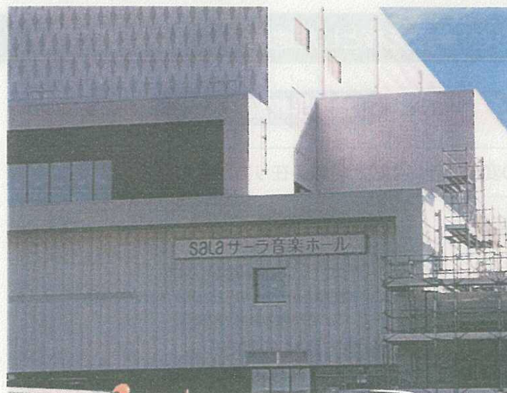
↑<ホール西側壁面> 撮影：神間郁子
