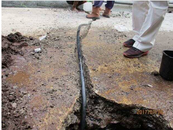
【給水工事の様子】
