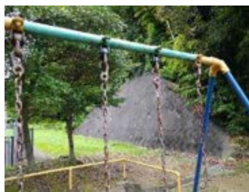
(吊り金具破損)
