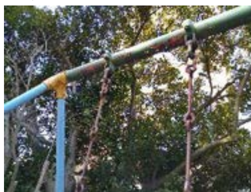
（塗装の剥がれ）
