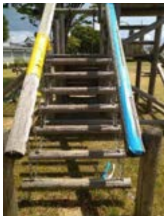
(テープによる補修)
