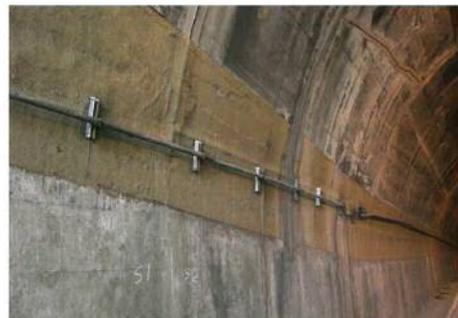
付写真 2.10 鋼材の接着例（左）・繊維シートの接着例（右）
