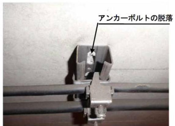
付写真 2.12 固定金具の腐食とアンカーボルトの脱落の例
