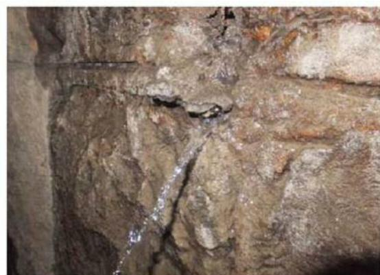
付写真 2.7 漏水（噴出）している例
