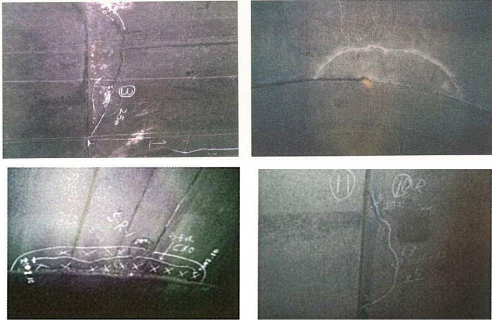
付写真 2.1 横断方向目地の天端付近に発生した半月状のひび割れの例
