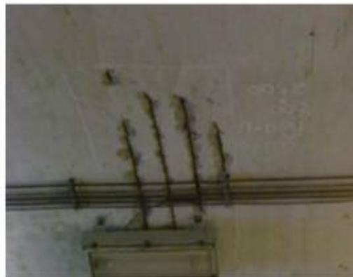
付写真-2.2 鋼材腐食の例
