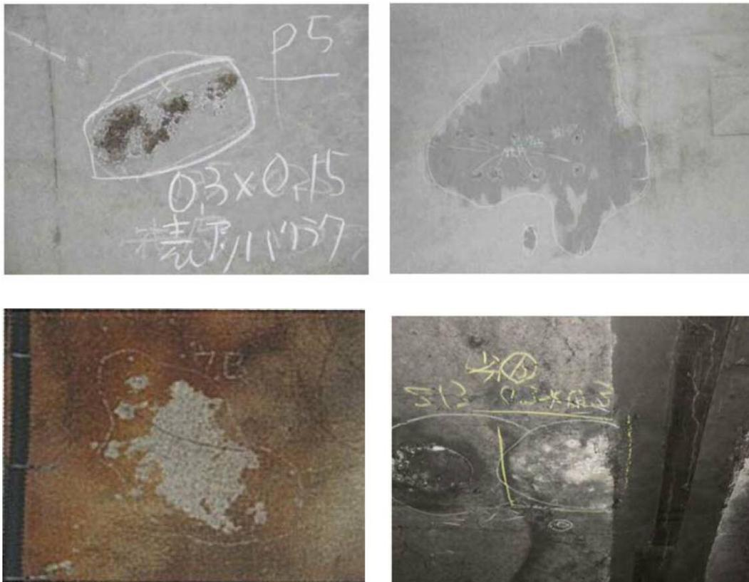
付写真 2.6 覆工コンクリートが変色している例
