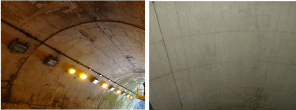
付写真 2.3 覆工の天端付近に発生した縦断方向のひび割れの例
