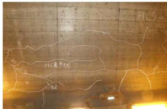
付写真 2.5 複数のひび割れで覆工コンクリートがブロック化している例
