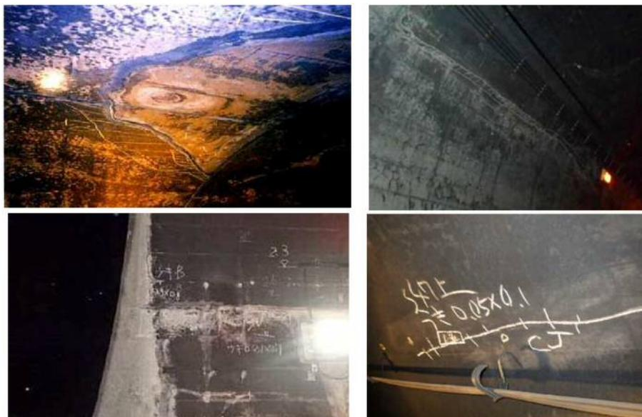
付写真 2.11 コールドジョイント付近に発生したひび割れの例
