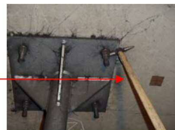
打音検査の例
