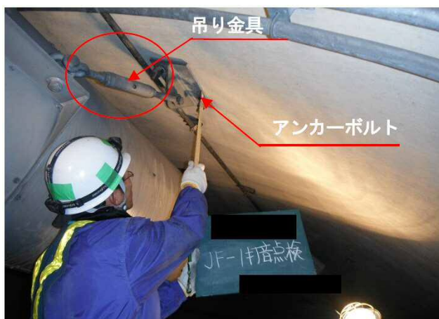
写真-解 6.3 打音検査作業状況（附属物等）
