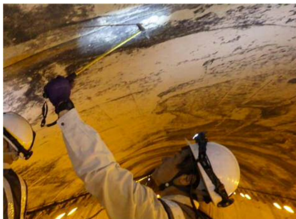
写真-解 6.2 打音検査作業状況（施設本体）
