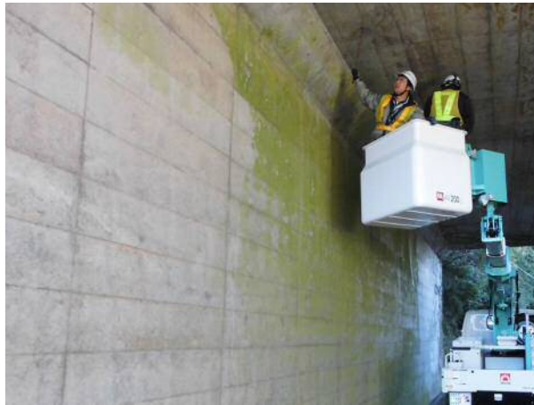
写真-解 6.1 近接目視作業状況
