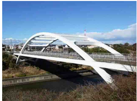
【アーチ橋】大平大橋（市道大平台4号線）
