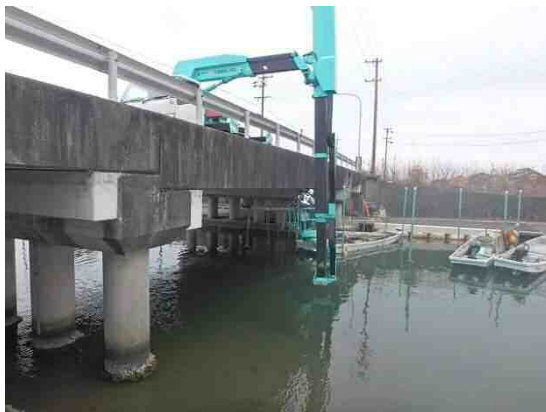
写真 4-1 橋梁点検車による近接目視点検
