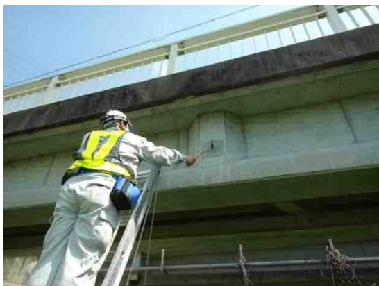
写真 4-1 橋梁点検車による近接目視点検
