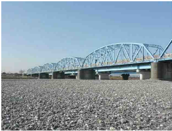
【トラス橋】天竜川橋（県道磐田細江線）
