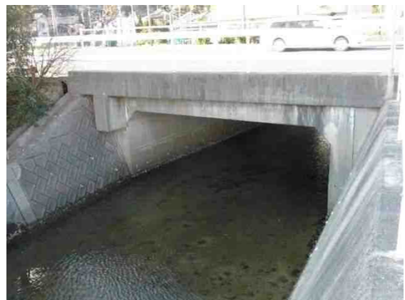
【溝橋】岩根橋BOX橋（国道362号）
