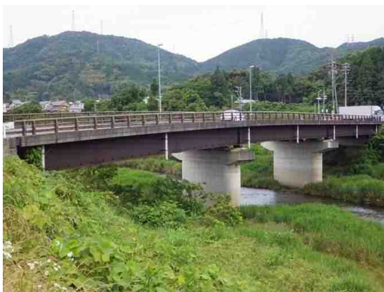
【桁橋】藤渕橋（国道362号）
