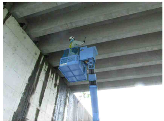
写真 4-2 高所作業車による近接目視点検
