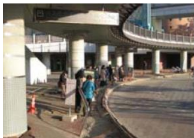
浦安市における地盤沈下の被害例
