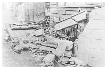
宮城県沖地震におけるブロック塀倒壊による被害例（出典：仙台市ホームページ）
