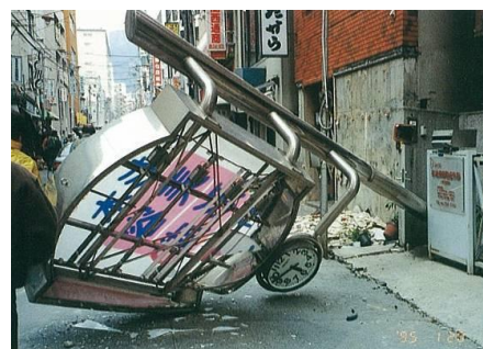
屋外物の落下による被害例 （出典：「阪神・淡路大震災被害調査報告書」（社）建設コンサルタンツ協会）
