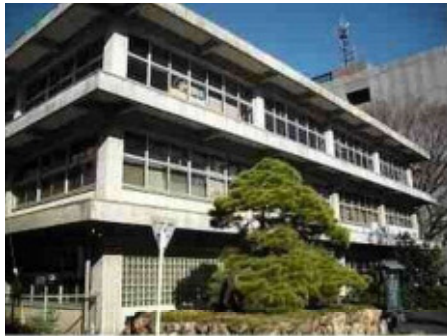
【本庁舎・西別館】解体・浜松城公園用地活用
