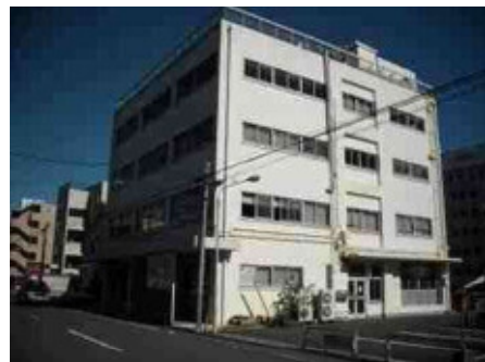
【本庁舎・南別館】解体・処分
