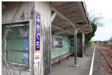
宮口駅プラットホーム&待合室
