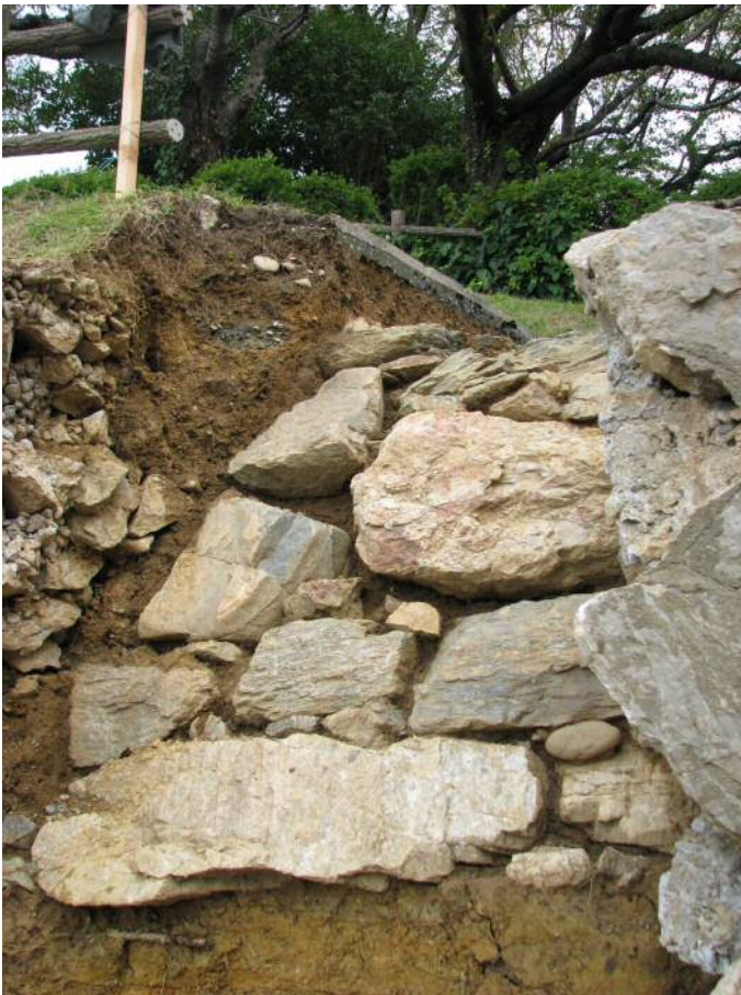
浜松城 発掘調査より「本丸南土塁の石垣」 自然の石を用いた野面積み（のづらづみ）の技法が見てとれる
