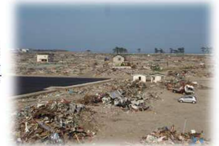
写真 東日本大震災における被災事例 (仙台中野小学校付近。海岸から約1km)
