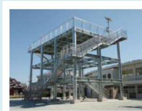
①津波避難タワー
