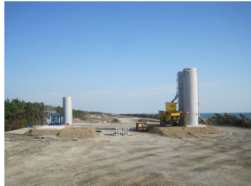
CSG混合機設置
