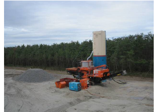
材料搬入・混合工
