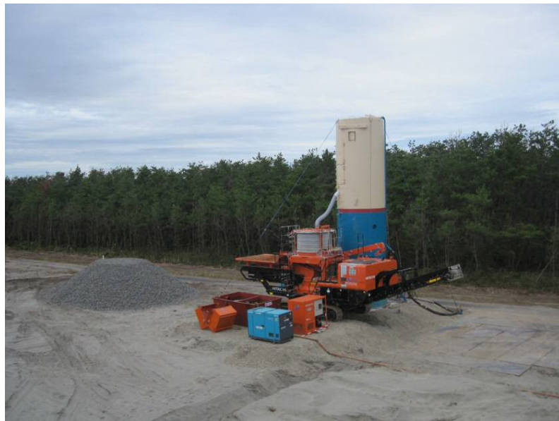
CSG混合機設置
