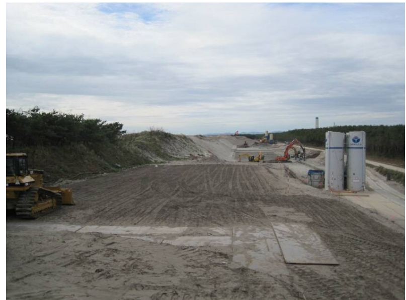
レーン施工ヤード造成
