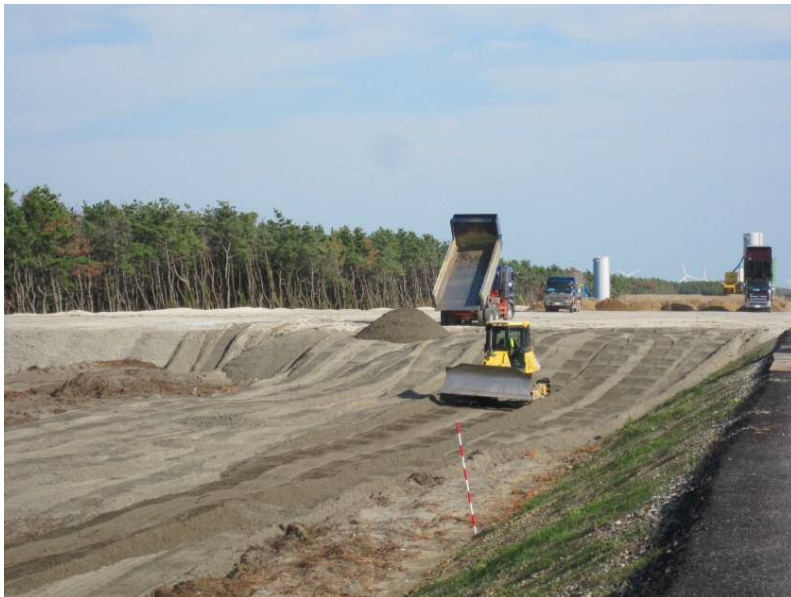
ストックヤード造成
