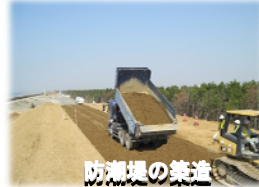
防潮堤の築造
