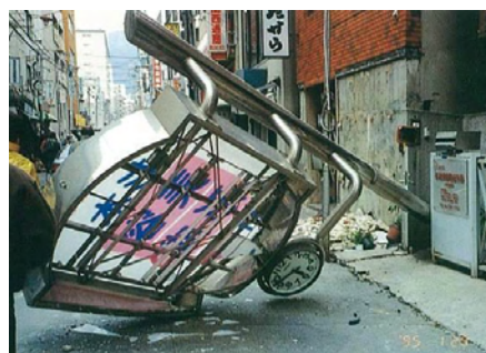
屋外物の落下による被害例 （出典：「阪神・淡路大震災被害調査報告書」（社）建設コンサルタンツ協会）
