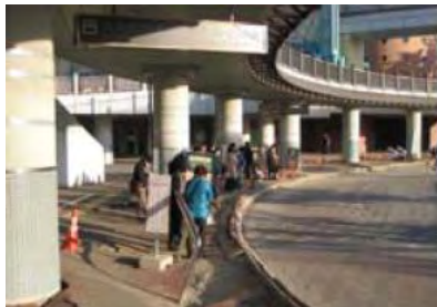
浦安市における地盤沈下の被害例
