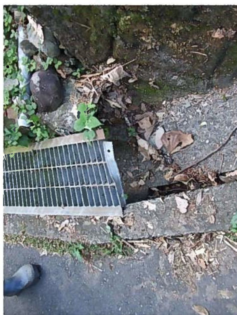
道路山側(背後地形)の段差亀裂
