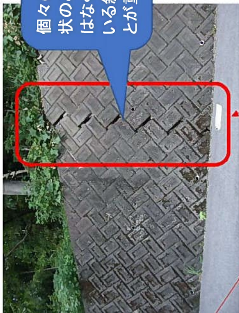
ブロック積擁壁の変形、ずれ亀裂
