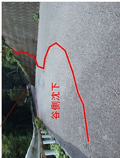
ブロック積擁壁の変形、ずれ亀裂
