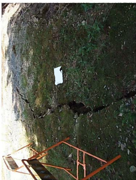
道路山側(背後地形)の段差亀裂
