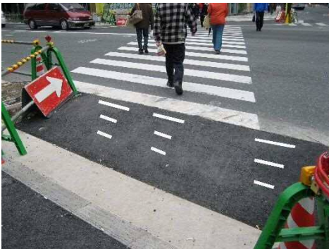
[段差をすり付け、路面表示により段差を示した例]
