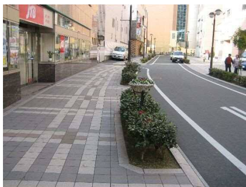
〔歩道等と車道の区別及び横断防止に植樹帯を設置した例〕
