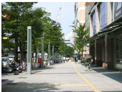
[デザインに配慮した歩道照明灯の例]
