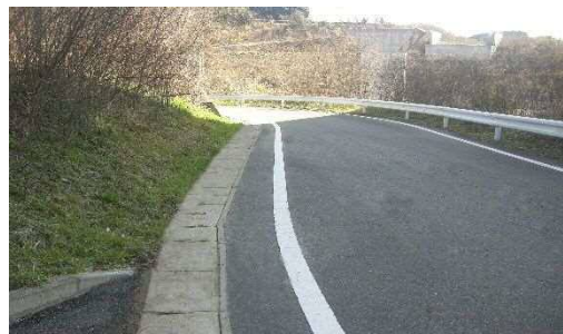
[側溝蓋を設置した例]
