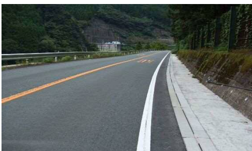
[円型側溝を設置した例]
