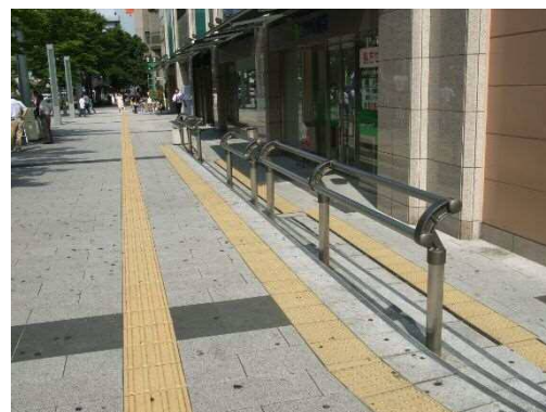
〔転落防止柵を利用した休憩施設の例〕 ※写真は民間による設置例
