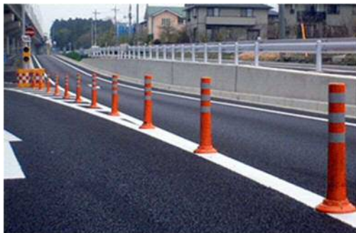
[中央線に車線分離標を設置した例]
