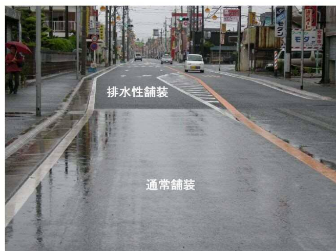
[排水性舗装の施工例]
