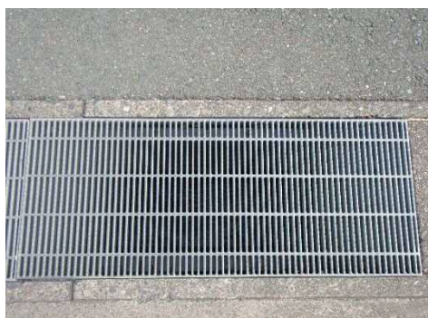
[細目ノンスリップ蓋を設置した例]
