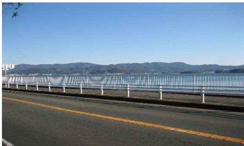
[ガードパイプを設置した例]
