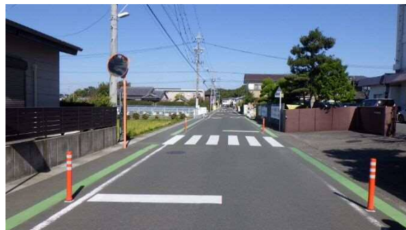
[車線分離標を設置した例]
