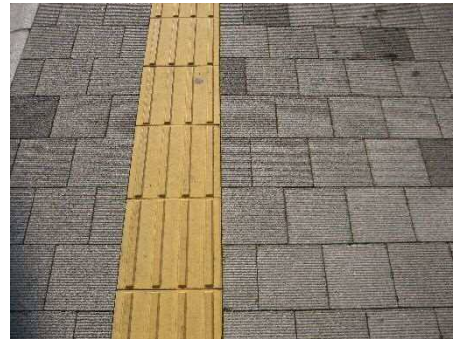
[透水性平板ブロック施工例]
