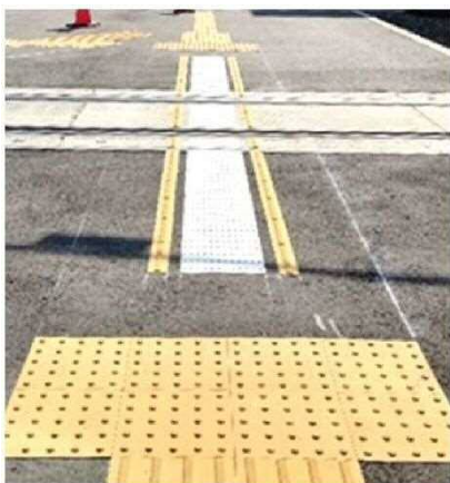
[歩道等及び自転車歩行者専用道路等の幅員が概ね2m以上の場合の設置例]
