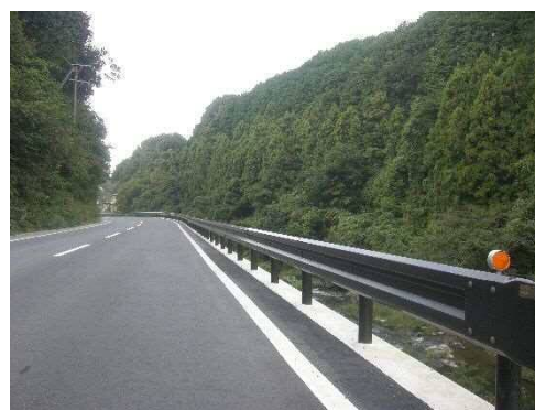
[景観形成に配慮した色彩の ガードレールを設置した例]
