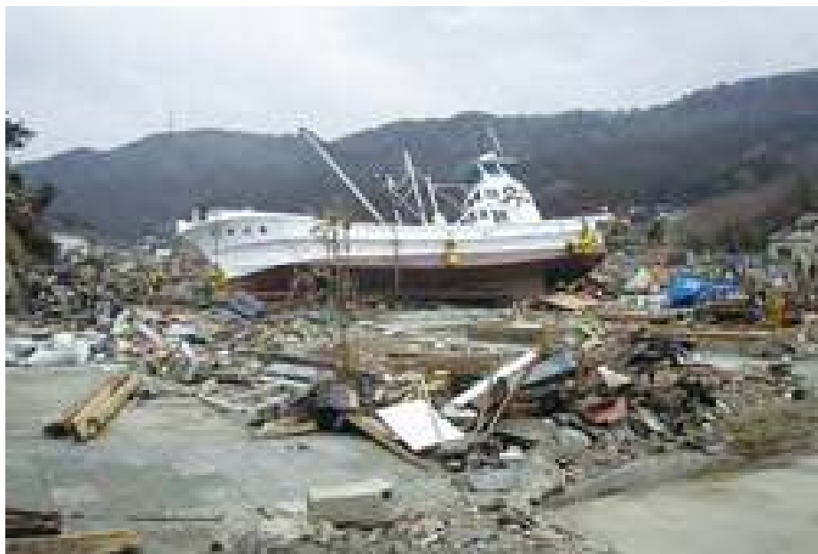
■ 漁港施設内の瓦礫散乱・打上げられた漁船（石巻市鮎川漁港）
