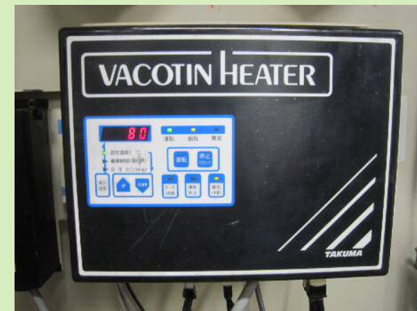
ボイラー設定パネル
