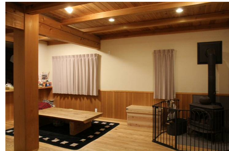
【天竜材が使用された木造住宅】 12
