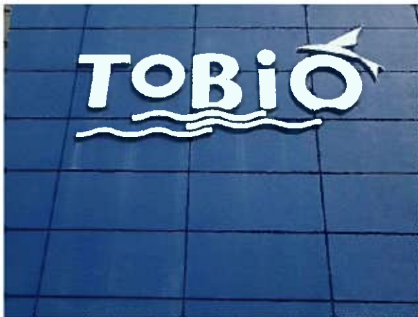
外壁塗装 複層吹付タイル異常なし 異常なし
