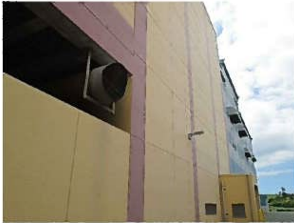
外壁 ALC版横張り防水型複層塗材も 異常なし
