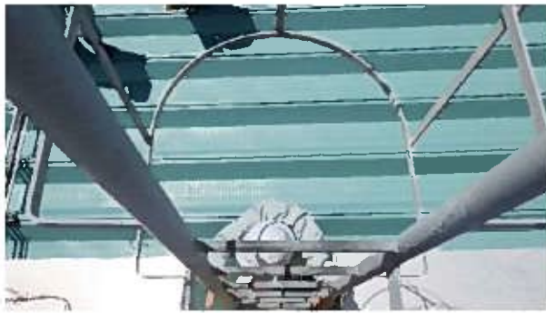
屋根 フッ素樹脂塗装鋼板 異常なし
