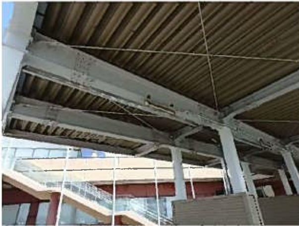
身障者用駐車場 鉄骨部 目立った錆びは無い（塗り直し無し）
