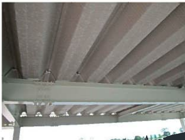
身障者用駐車場 屋根の梁鉄骨部 塗装の塗り直しをH28年に行なっている
