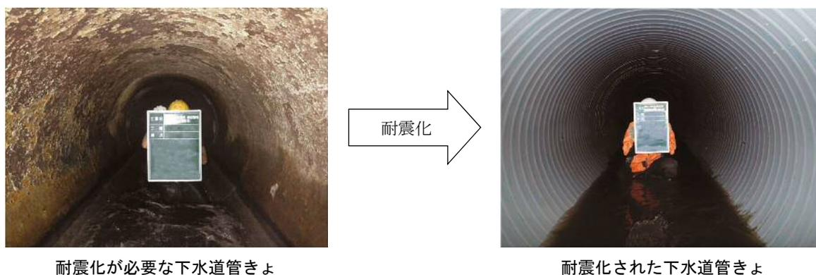
図 2-1-2-1 下水道管きよの耐震化（管更生）
