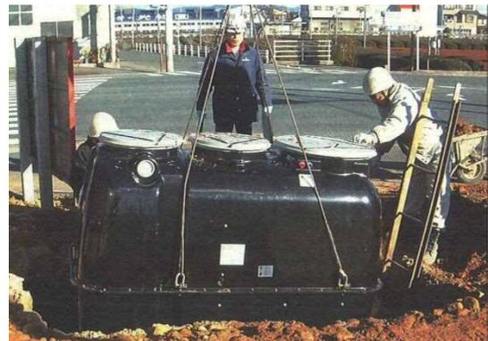
合併処理浄化槽の設置
