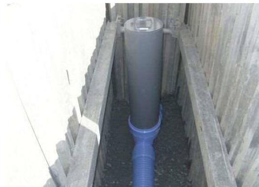
小口径マンホールの採用による材料費、設置費の削減
