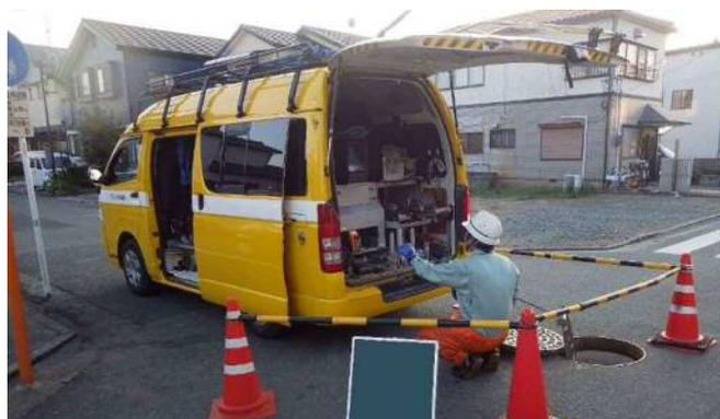
図 4-5-1-3 予防保全のための点検（下水道管きよの点検）
