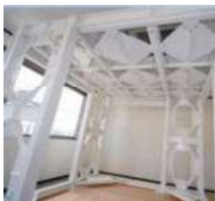
耐震TBシェルター「鋼耐震」 (仕上げ工程前)
