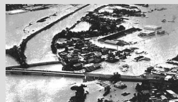
都田川と井伊谷川の合流部周辺における浸水被害の状況(1971年)
