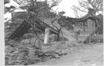
六所神社社殿の倒壊(中野町)
