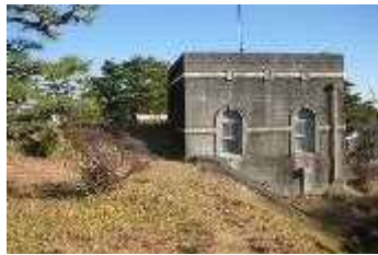
タイルの帯 (配水池(塔屋部分))
