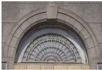
欄間の格子 (配水池(塔屋部分))
