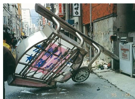
屋外物の落下による被害例
