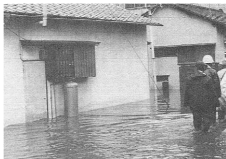
堀留川のはん濫による床上浸水の様子(旧可美村、1975年)
