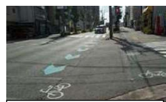
自転車通行空間整備
