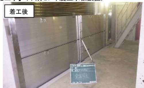
【西遠浄化センターにおける耐水化工事】（平成29年度止水板設置）
