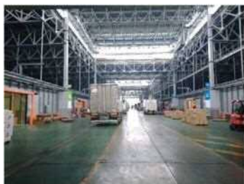
卸売場西棟の入荷用通路
