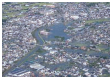
台風第15号で浸水被害があった安間川周辺
