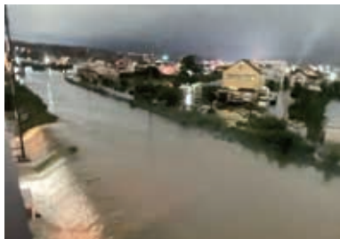
台風第15号により越水した五反田川
