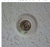
(バッテリー内蔵式非常用照明装置の例)
