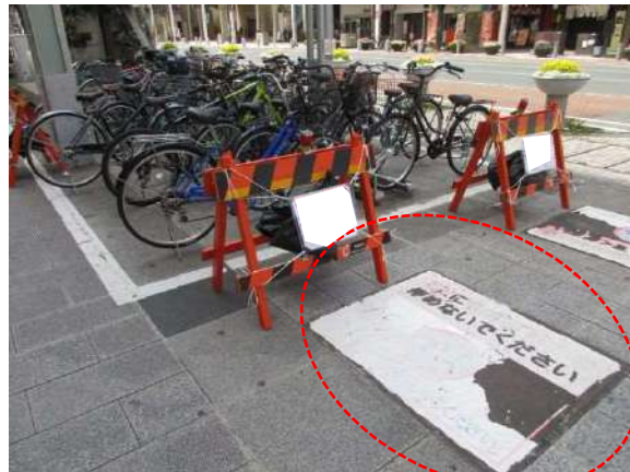
図 43- 駐車場の注意喚起標識の劣化状況
