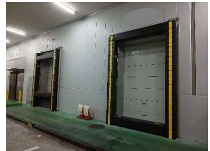
ドックシェルター付きトラックバース
