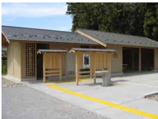
ビクターセンター（トイレ・休憩所併設） の整備事例
