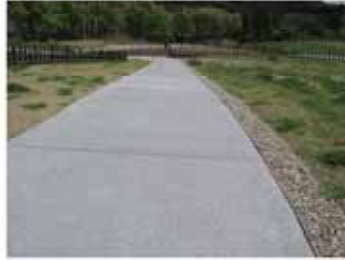
園路の整備事例 (透水性コンクリート舗装)
