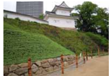
岡崎城東隅櫓付近の土塁の復原
