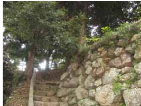
14 石垣上端を傷めている。右上側の木は、すでに石垣を崩し始めている。
