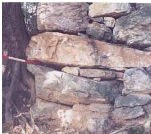
6 天守曲輪南西隅 【平成元年度】
