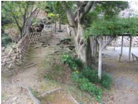
10 樹根が土塁内に侵入し、石垣を背後から傷める原因となっている。
