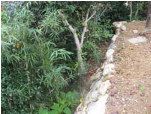
4 石垣上に堆積した土砂に生育し、石垣内に樹根が侵入する原因となっている。
