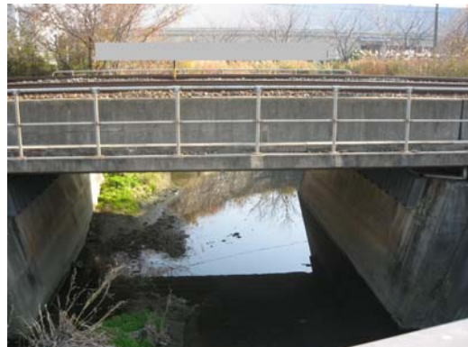
4.準用河川・宮井戸川が二級河川北裏川となる地点。 北裏川は芳川に合流する。
