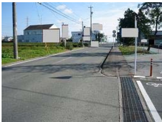
9.高校近くの道路の歩道自転車道未整備 (浜工北側道路)
