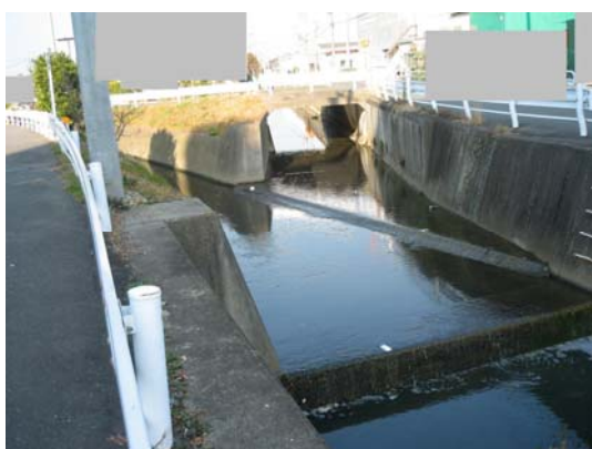
2.準用河川・宮井戸川に北裏都市下水路 1,585mが合流する地点
