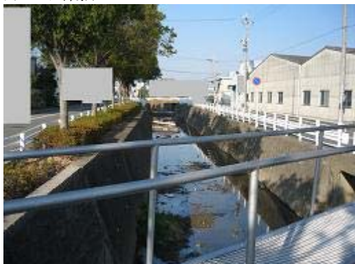
1.準用河川・宮井戸川 674m 片側は植樹帯になっている。
