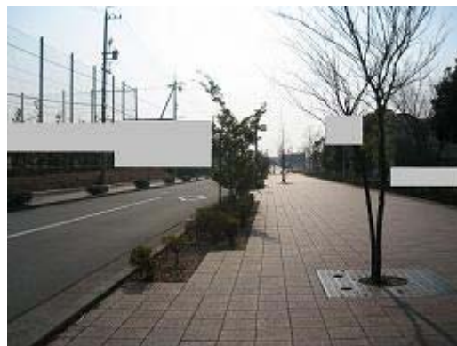
18.佐鳴湖西岸の歩道は車道より広く、無駄なコストが支出されている。
