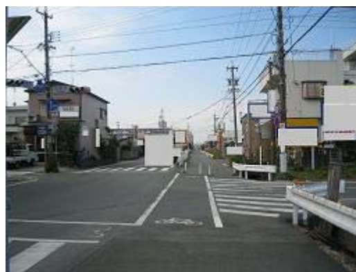
5.道路が2本並行している間に、柵が設置 (市野町)
