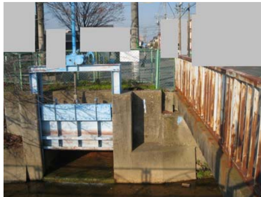
9.準用河川・曳馬川に流れ込む普通河川(排水路)曳馬 6 号線 914m
