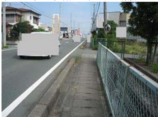
7.狭い歩道の横にフェンスと排水路 (笠井街道)
