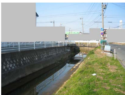
3.準用河川・曳馬川 2,842m 片側は、幅のある土手になっている。
