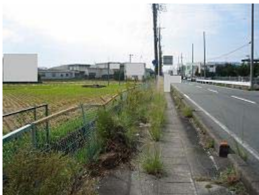
8.歩道を雑草が埋めている (笠井街道)
