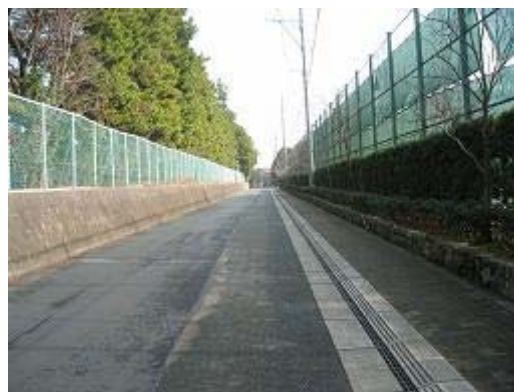
17.車がほとんど通らないのに、浜松市立高校北側にタイル敷き歩道が設置されている。
