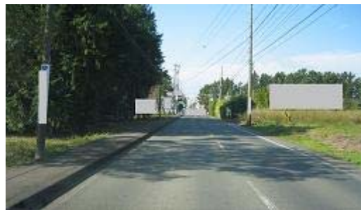
10.高校近くの道路の歩道自転車道未整備 (浜工北側道路)
