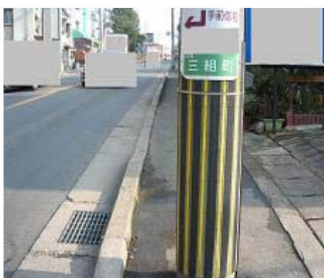
14.歩道の真ん中に電柱が立っている。
