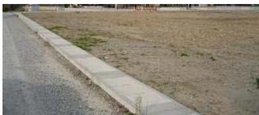
4.中瀬南部 養護学校予定地は歩道の計画がない。
