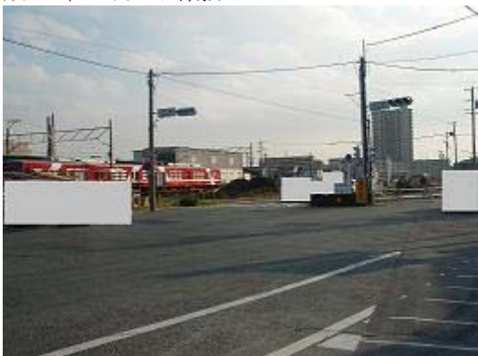
8.上島駅周辺区画整理区内 (工事中)
