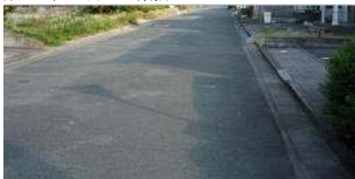
1.都田区画整理地内 (H5 完成) 歩道がない
