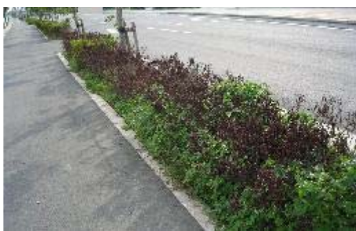
3.県道(浜北区) 歩道の植樹が枯れている。
