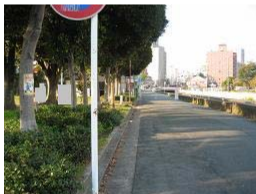
6.海老塚区画整理区内 (S53 完成) 入口付近に歩道がなく、緑地帯になっている。
