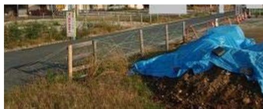
7.高竜区画整理区内 (工事中) 再々延長がされている。
